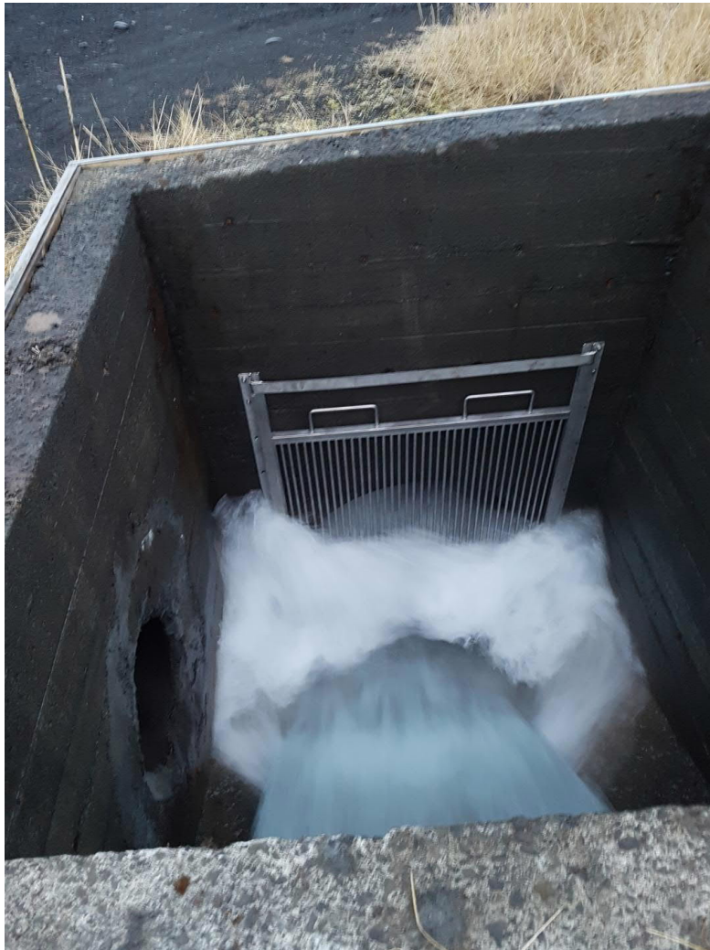
Mynd 3.7 Fiskgildra í frárennslu frá eldisstöð á leið til sjávar.
